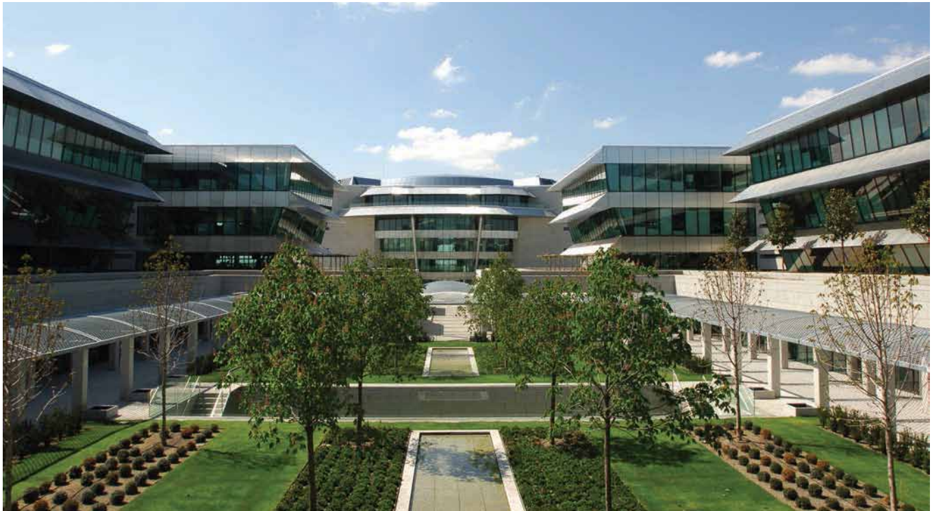
Edificio Pereda, Ciudad Grupo Santander, Boadilla del Monte, Madrid.
